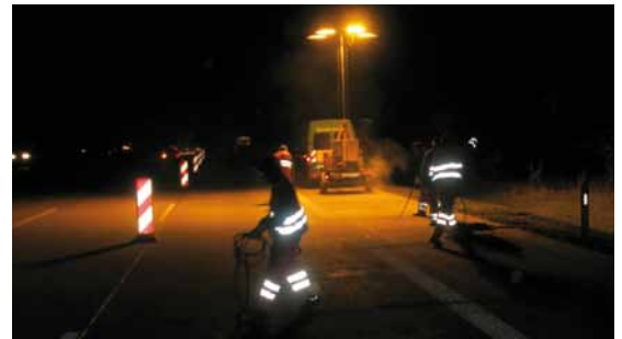
Erhaltungsmaßnahmen als Nachtbaustelle
