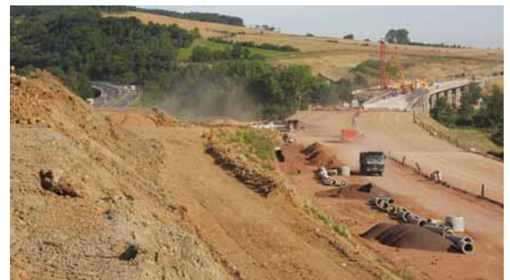
Neubau der Umfahrung
