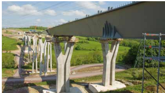
Neubau der Nesselstalbrücke
