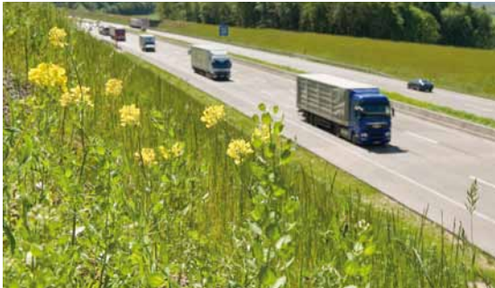
Straßenbauer und Naturschützer arbeiten Hand in Hand
