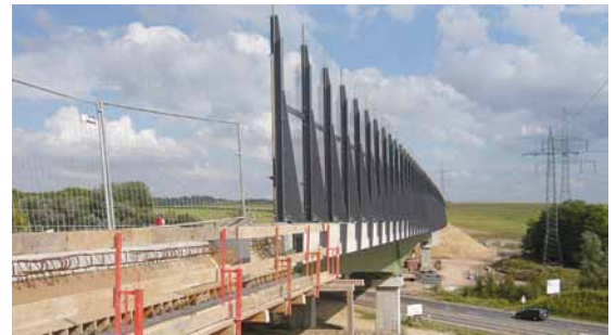
Neubau der Böbertalbrücke
