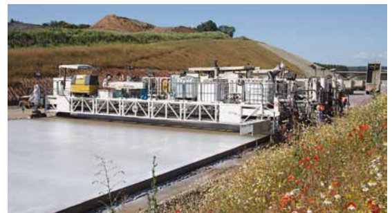
Betonage der Strecke
