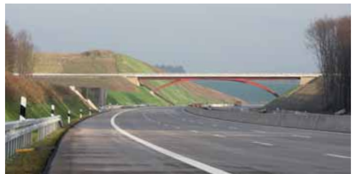
Blick auf die neue Autobahn mit Bauwerk 5521-06.
