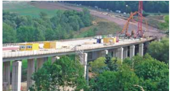
Die südliche Fahrbahn der Hörseltalbrücke wird zügig betoniert.
