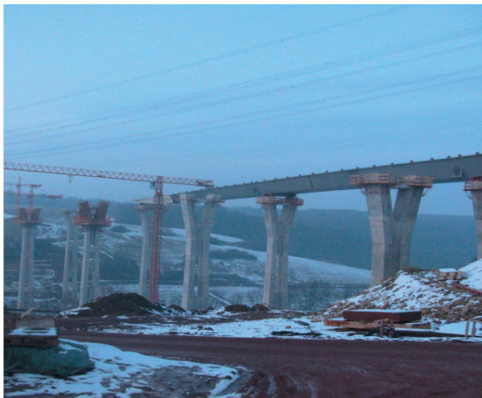
Die 414 Meter lange und 55 Meter hohe Nesselbrücke entsteht im Takt-schiebeverfahren.
