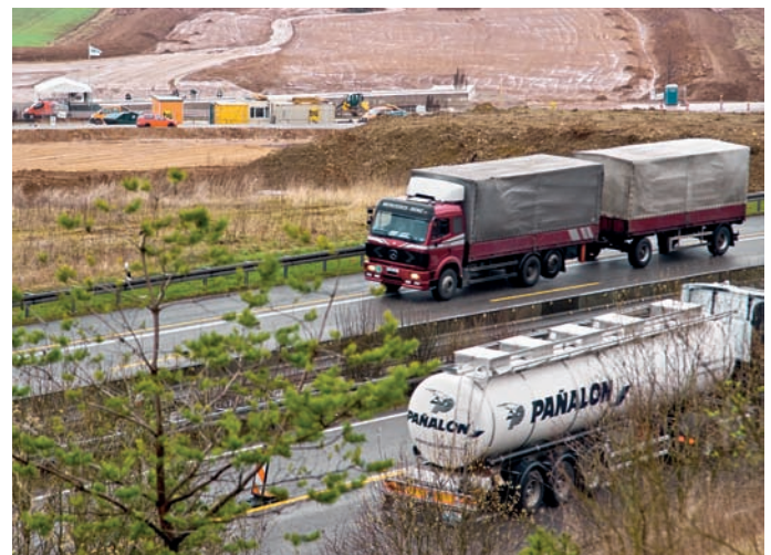
Bauarbeiten in vollem Gang: Von der bestehenden A4 aus kann man die Dimensionen der neuen Strecke bereits erahnen
