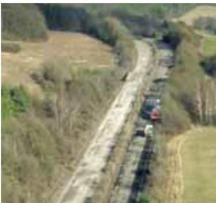
Rückbau der alten A4 in den Hoeselbergen.
