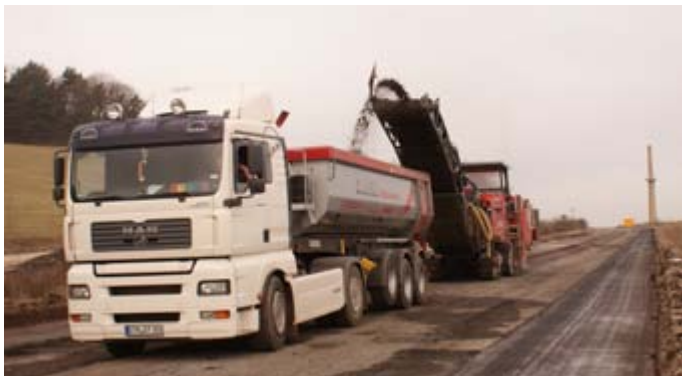
Beim Rückbau der Asphaltsschicht wird eine Großfräse eingesetzt.
