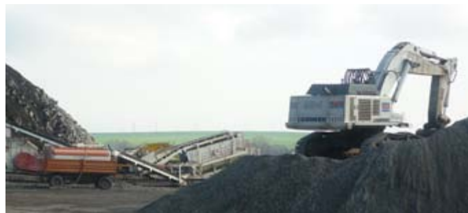
„Aus alt mach neu“: Die mobile Brecheranlage in Sättelstädt zerkleinert Teile der alten Autobahn für das Recycling.
