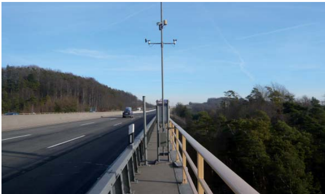
Die Glättemeldeanlage warnt rechtzeitig vor Glättebildung
