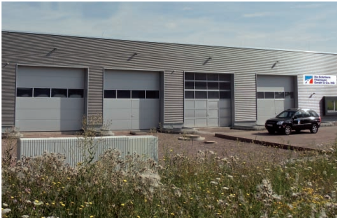
Optimierter Betriebsdienst der neue Via-Solutions-Stützpunkt in Sättelstädt
